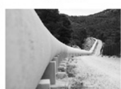
Canonada de distribució, 405 km
