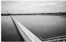
Dipòsit d'aigua crua
